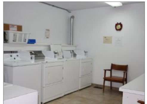
Salle de lavage
